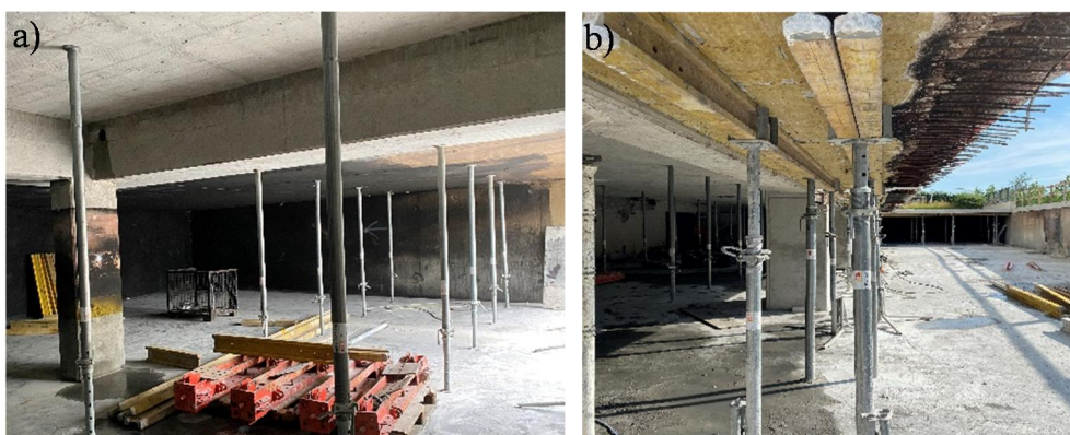
Rys. 12. Podparcie zabezpieczające istniejący strop: a) punktowe b) liniowe
